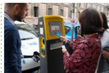
13. Appoggiare la **tessera blu** sul sensore della **colonnina** per permettere lo scollegamento del cavo
